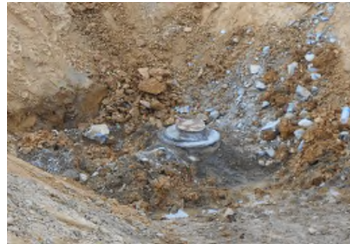
Scellement du puits
