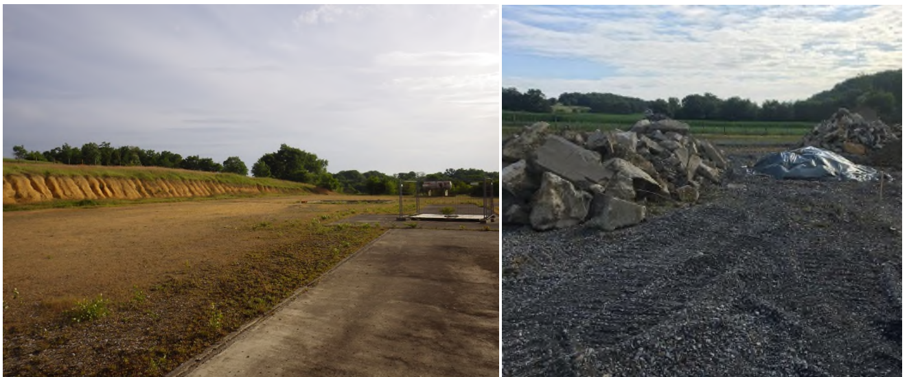
Figure 3 : Photographies illustrant le démantèlement des infrastructures de surface
