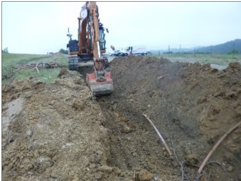
Figure 4 : Photographie illustrant le retrait des réseaux enterrés
