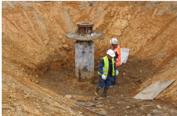
Destruction du béton et découpe au chalumeau
