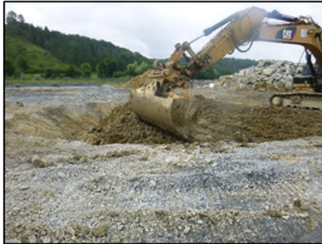
Figure 7 : Photographie de la phase de remblayage
